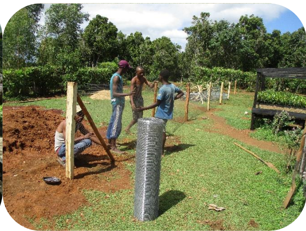
Photo 2: Installation de clôture en grillage métallique
