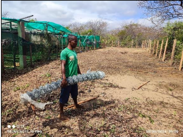
Photo 2 : Mise en place de grillage
