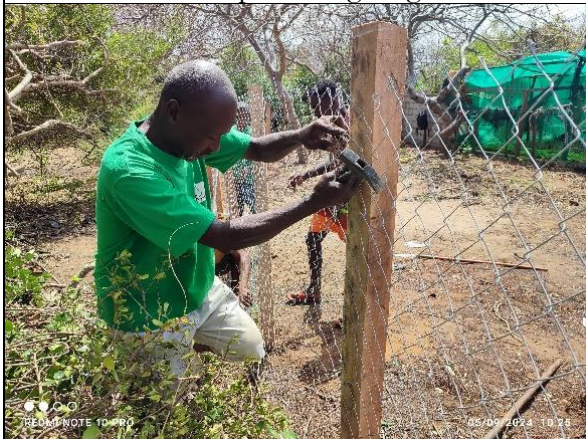
Photo 3 : Mise en place grillage
