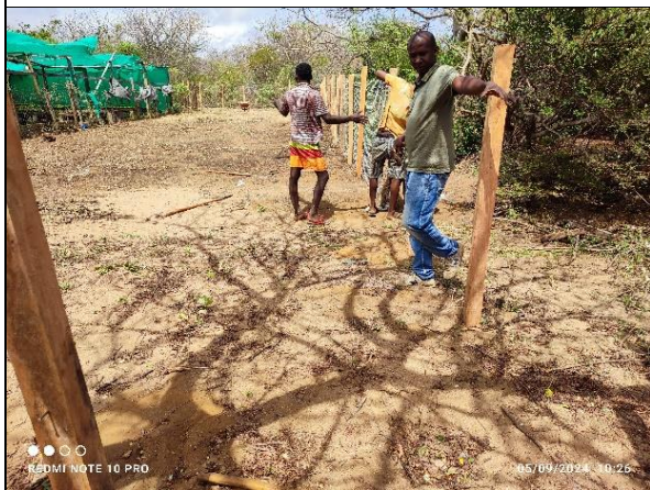
Photo 5 : Réparation de la clôture
