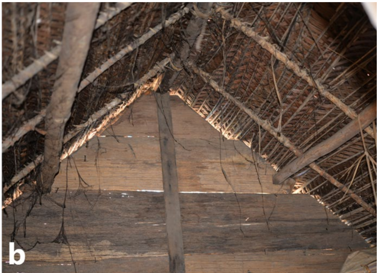
Figure 26. Cabanes avec une toiture en feuilles de Dypsis fibrosa dans la région d'Ifanadiana. a) vue de l'extérieur, la paroi de la cabane est constituée de bois et sa toiture est composée de la superposition, l'une sur l'autre, des centaines de feuilles de ce palmier, b) disposition des feuilles pour la toiture en feuille de palmier, vue de l'intérieur de la cabane. (photos : R. Rakotomanandriana).
