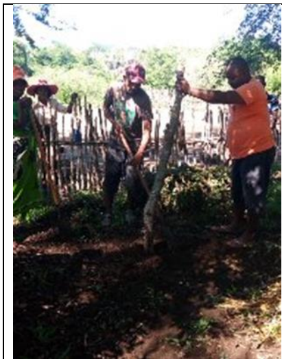
Photo 4 Installation d'un bois rond au centre
