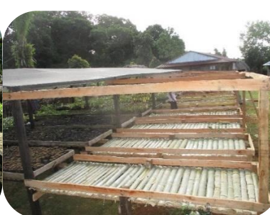
Photo 18: Extension de pépinière de Matanga
