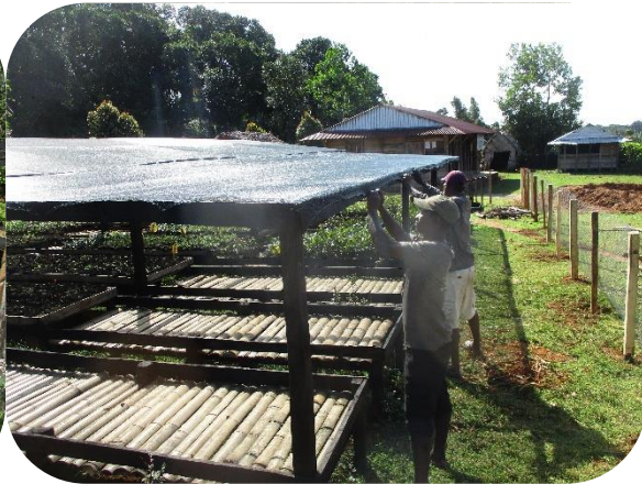
Photo 8: Montage de l'ombrière
