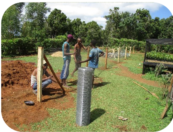
Photo 7: Installation de clôture
