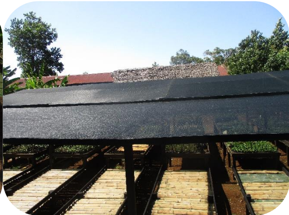
Photo 10: Ombrière de Vohipaho
