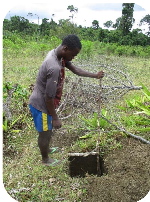
Photo 8: Vérification de la taille des trous.
