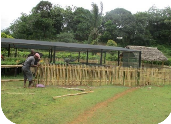
Photo 3: Construction de Clôture Matanga
