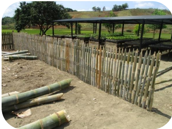
Photo 3: Mise en place de clôture à Antenindava
